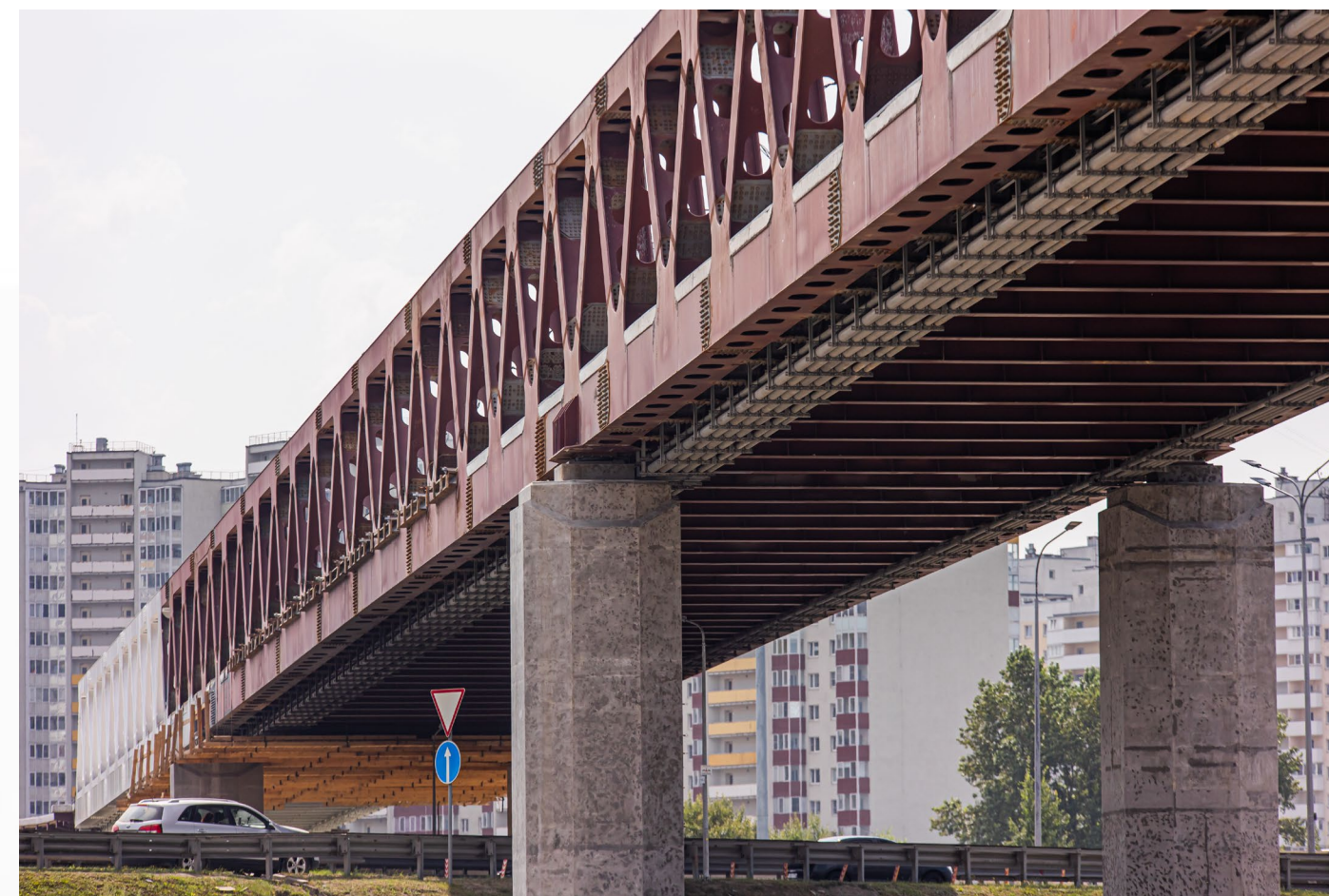
Ферменная конструкция путепровода через Южное полукольцо ж.д. и КАД.
